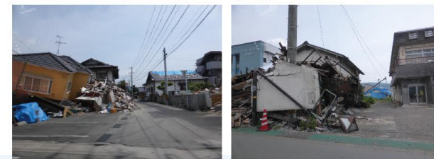
■被災から3か月後の熊本県益城町内の様子
